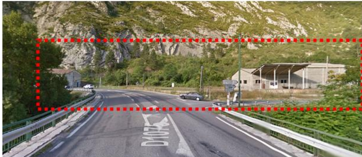
Vue sur le site en arrivant depuis le nord
