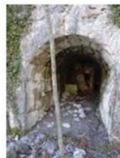
Four à Chaux Gauthier (5)
