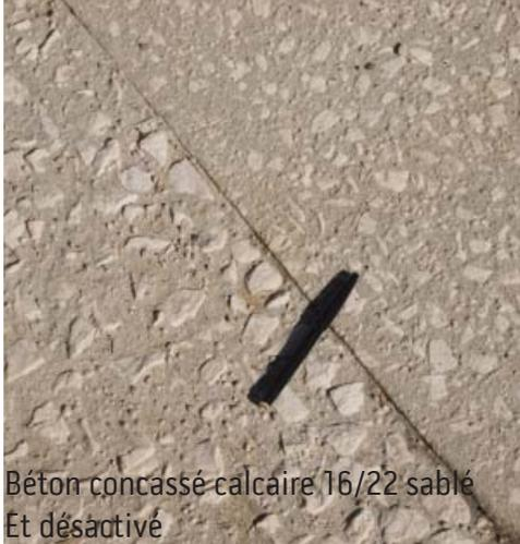
Béton concassé calcaire 16/22 sablé Et désactivé
